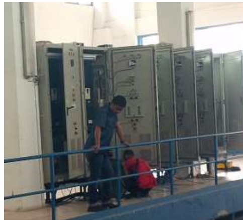
SYSTEM STARTER POMPA DENGAN INVERTER 250KW, 160KW, 90KW
